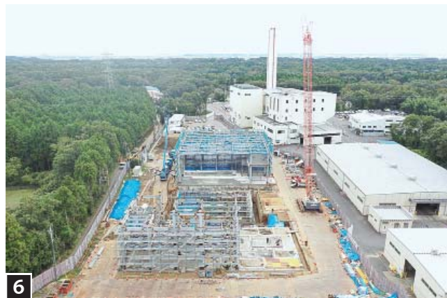
5 2020.9.29 管理棟：鉄骨建て方、ごみピット：地下 躯体工事、炉室：基礎工事
