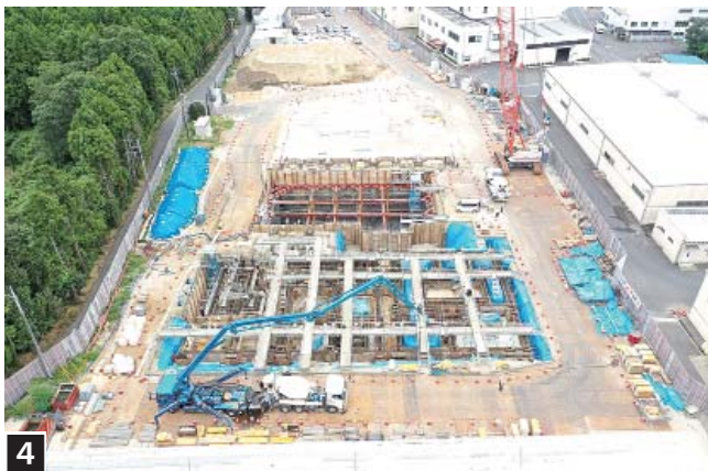
3 2020.7.29 管理棟：基礎工事、ごみピット：2次掘削、 炉室：基礎工事
